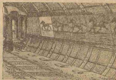
en cada lado del tubo por donde va el tren, iluminándolas sucesivamente por medio de lámparas colocadas detrás de ellas. Los circuitos de cada una de las luces podrían cerrarse por medio de un regatón que cada coche llevaría debajo y que al pasar se pondría en contacto con placas situadas a los lados de la vía.
