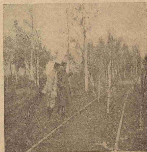
El teniente coronel Fossa, jefe de la sección de Estudios de Camouflage del Ejército francés, y el teniente camuflador Boucher, visitando el emplazamiento de la pieza número 1 de la segunda batería que bombardeó París. Obsérvese entre los rieles del pequeño tren de municionamiento de esta pieza, cómo están colocados unos pequeños árboles de quita y pon que durante el día impedían la visibilidad aérea del emplazamiento de la pieza.
