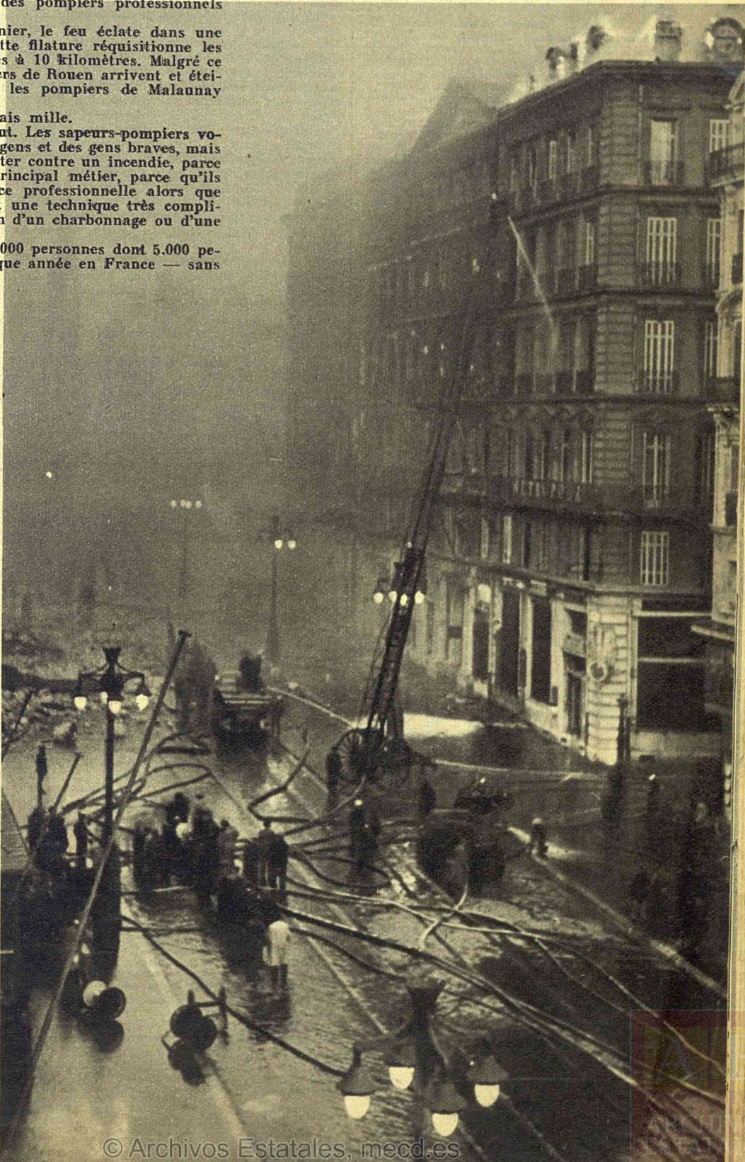
Le sinistre gagne du terrain. Les pompiers de Marseille défendent en toute hâte les immeubles voisins que le feu a déjà touchés.
