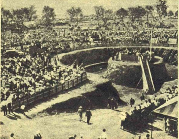
La foule va assister au coulage des fondations du « trylon », immense obélisque à 3 faces de 210 mètres de haut, qui dominera toute l'Exposition.
