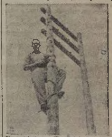
Un soldado de Transmisiones reparando una avería.
