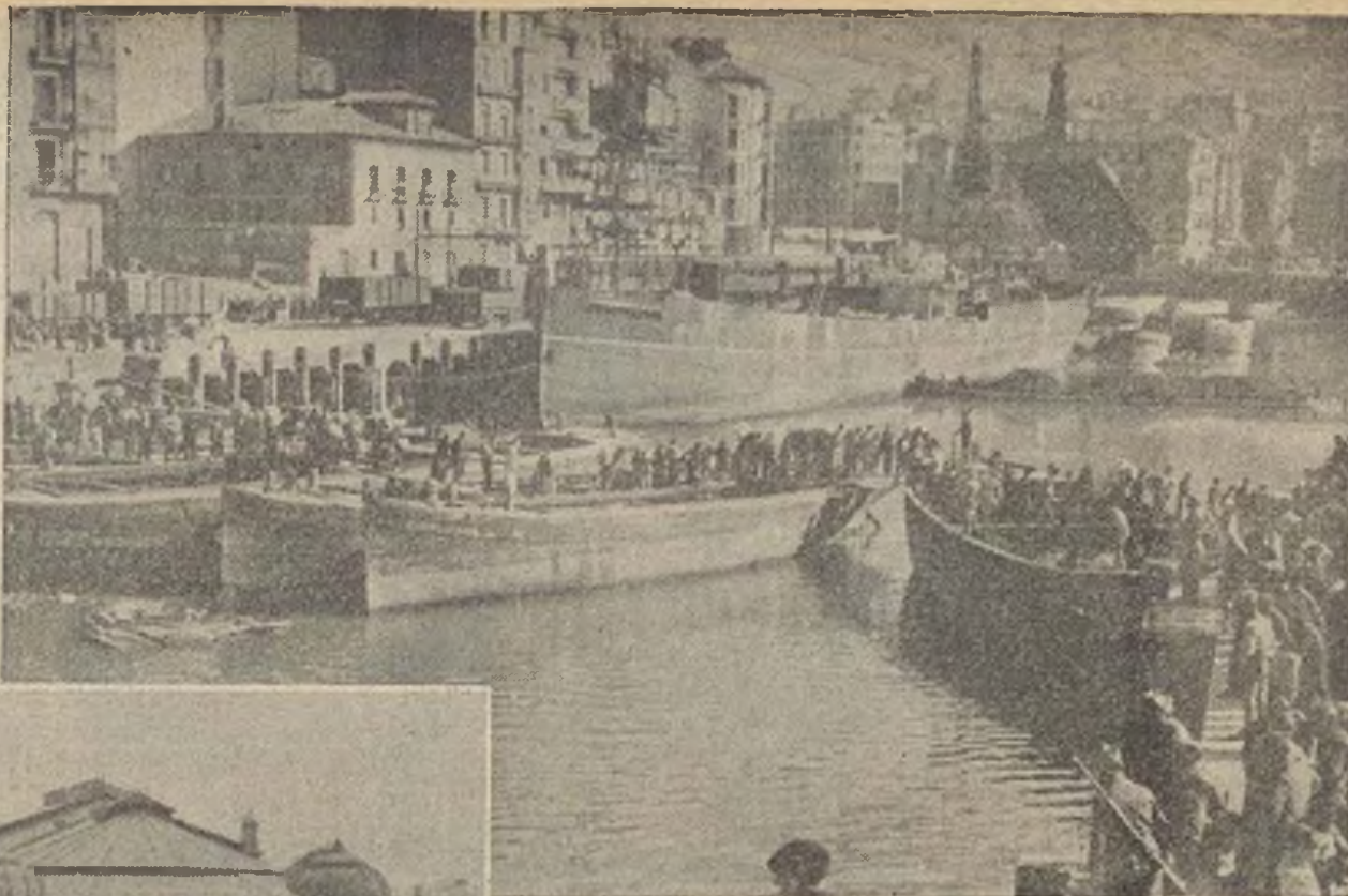
Puente de Isabel II, volado con dinamita.
