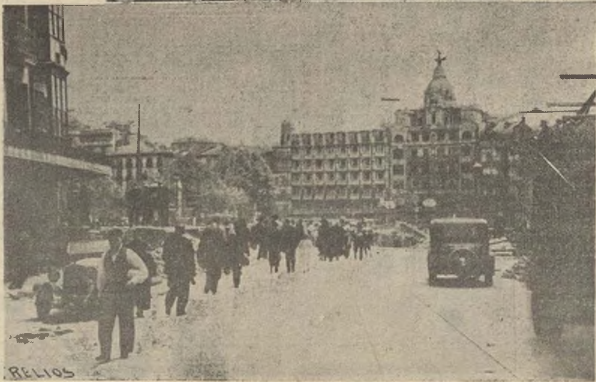
El público, haciendo cola, para atravesar el puente de barcazas. Otro aspecto del puente de Isabel II, volado con dinamita. Otra vista de la Plaza Circular o de la Estación.
