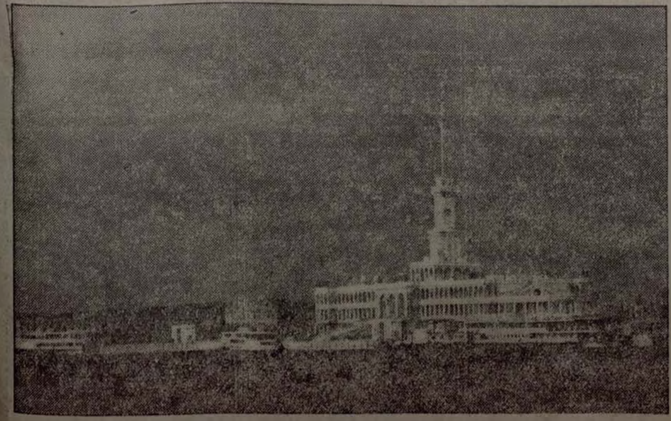
Las grandes obras de la U. R. S. S. El canal Moscú-Volga. En la foto, la estación del río en Jmki.
