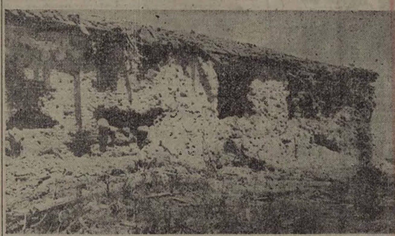
El único trozo de pared que ha quedado en pie en la Casa de Labor. (Foto Mayo.)
