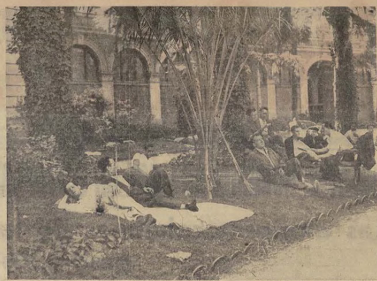
En el palacio de Medinaceli se ha establecido un hospital-cuartel, donde las Milicias obreras encuentran el merecido descanso de la lucha en el frente. ...
