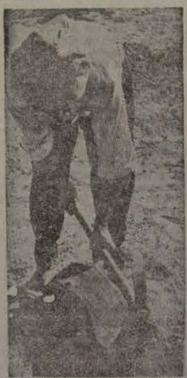
Un hombre del pueblo golpea al descanso sobre el duro madero para ponerle en condiciones de travesía para el ferrocarril (Foto Luis.)
