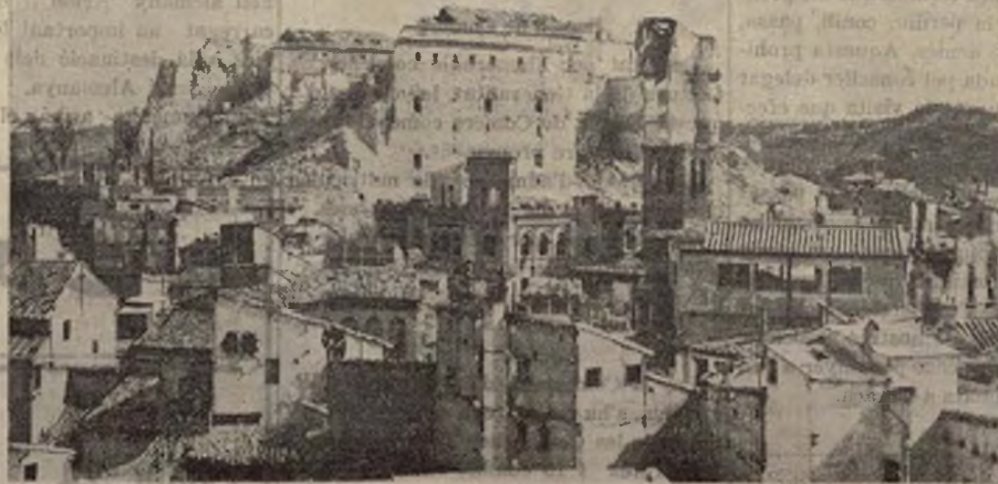
LA PRESA DE L'ALCASSER DE TOLEDO
