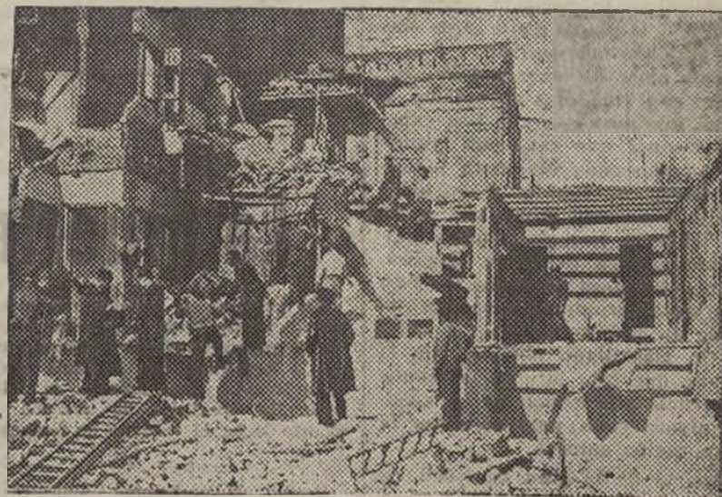
Barcelona. Casas destruidas por la aviación facciosa
