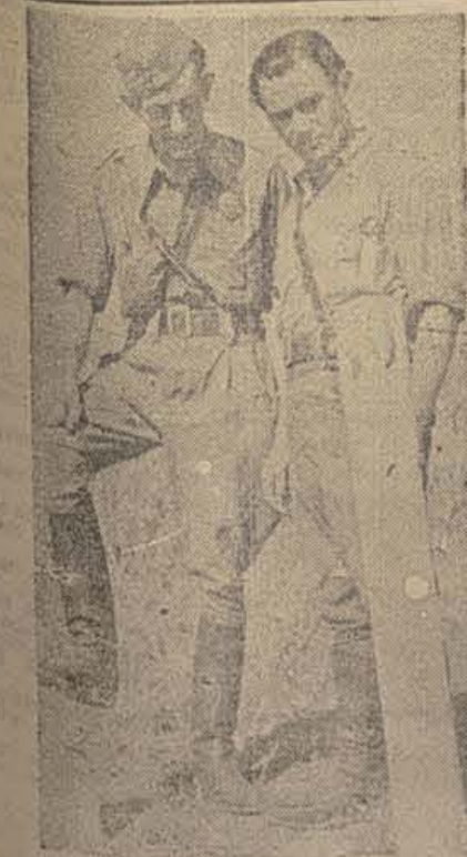
LEVANTE. — Un capitán y un comisario de Transmisiones inspeccionando las líneas que han de asegurar un buen servicio en todo el frente. (F. Maye)
