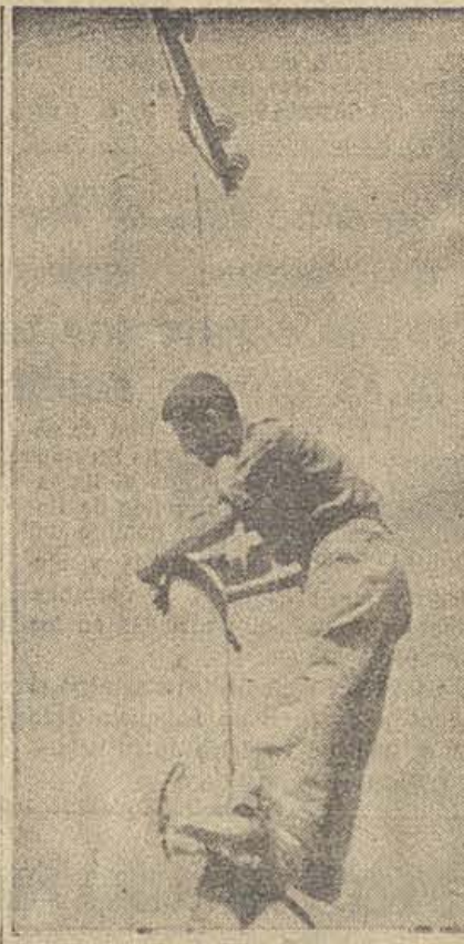
LEVANTE. — Un transmisionista repara una línea rota, como consecuencia de los bombardeos fascistas (F. Mayo)
