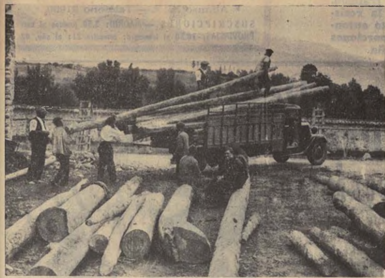
EN LOS FRENTES DE LA SIERRA.—Acarreo de madera para puentes y atirachamientos. (Foto Benítez Casaux.)
