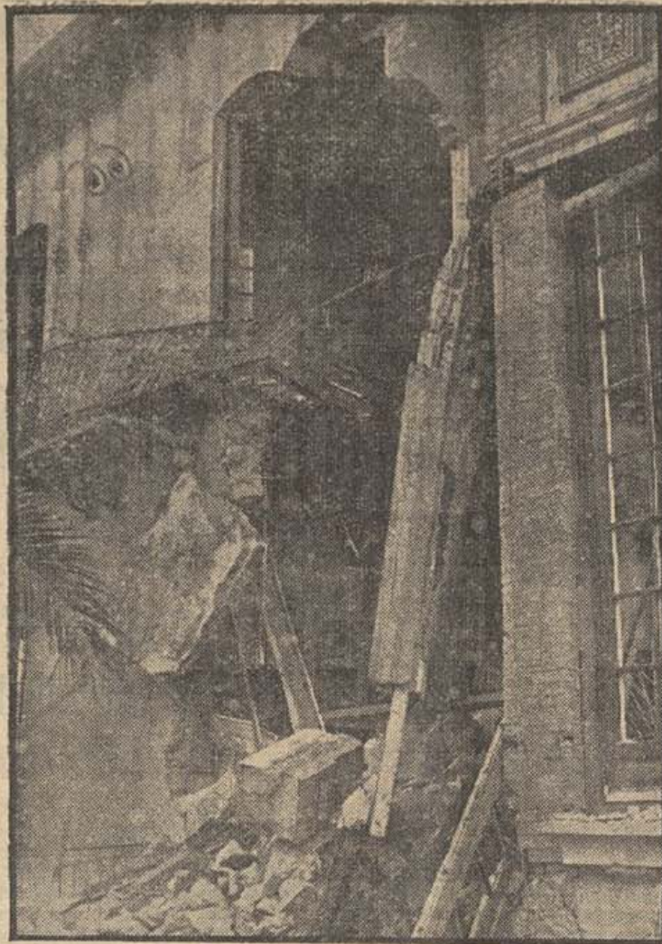
Del bombardeo de Almería.—Más casas destruidas por la escuadra alemana. Edificio del Socorro Rojo, destruido. (Foto Mayo.)
