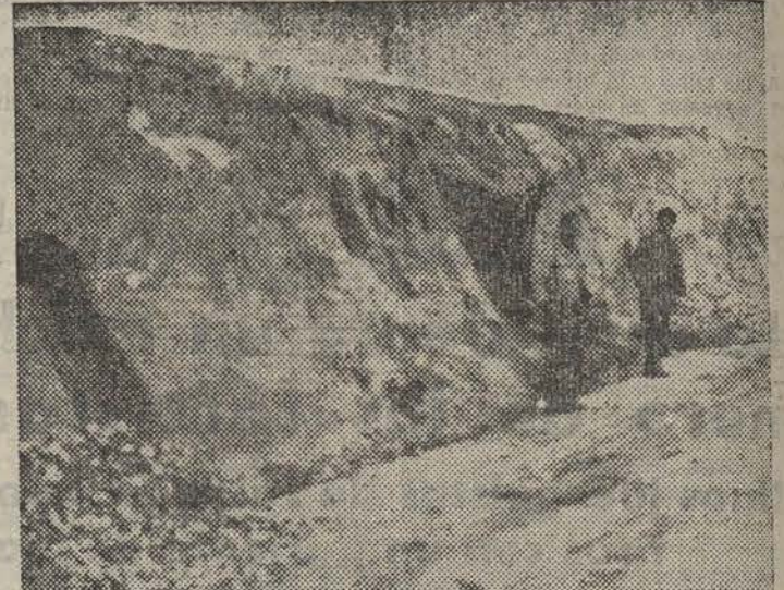
Frente El Pardo.—Entrada a una trinchera. (Foto Bajatierra.)
