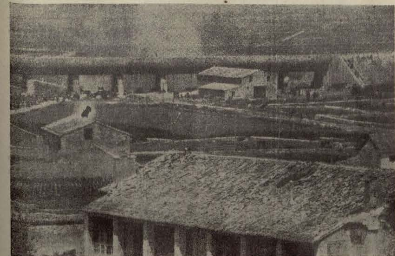
TARDIENTA.—Plaza del frente aragonés, tomada por las fuerzas leales. En la casa del primer término pueden verse algunos boquetes abiertos por la metralla. Al fondo, el acueducto.
