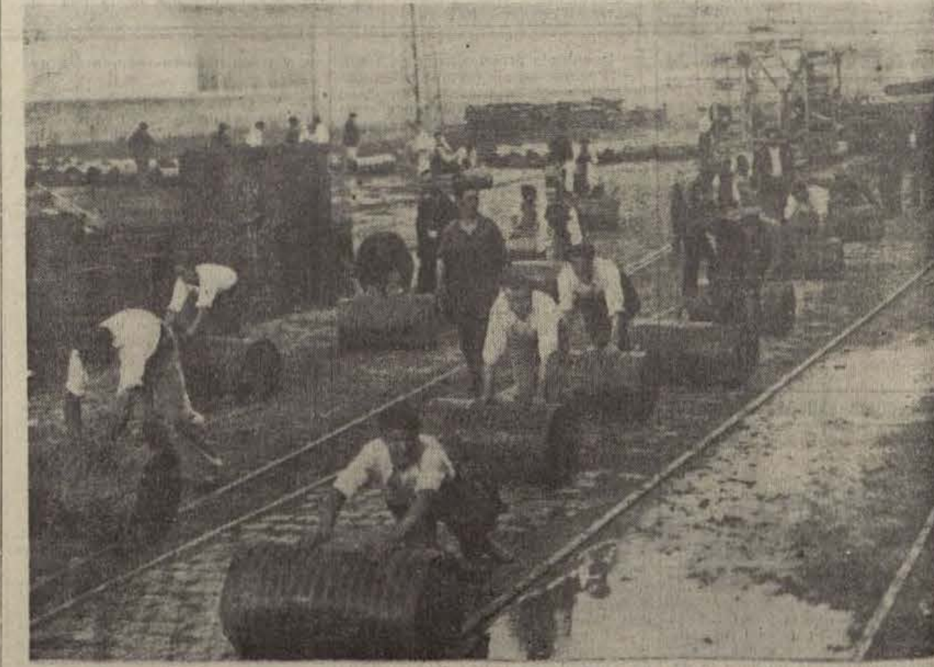
SANTURCE.—Brigadas de obreros retirando de la zona del Depósito Franco, un cargamento de harrites de alquitrán.
