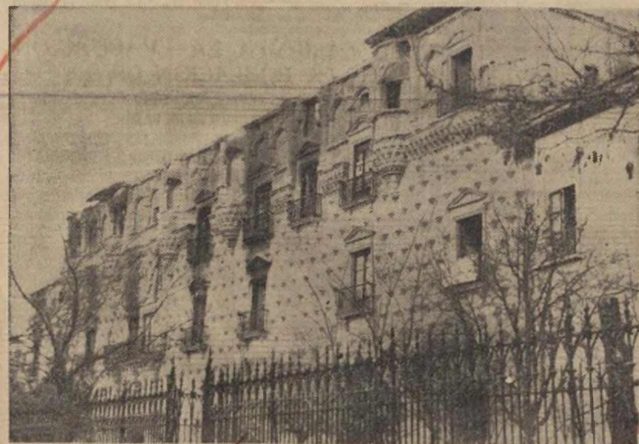
GUADALAJARA.—Los desperfectos causados por la metralla faccista en la magnífica fachada principal del palacio del Infantado. (Foto Mayo.)
