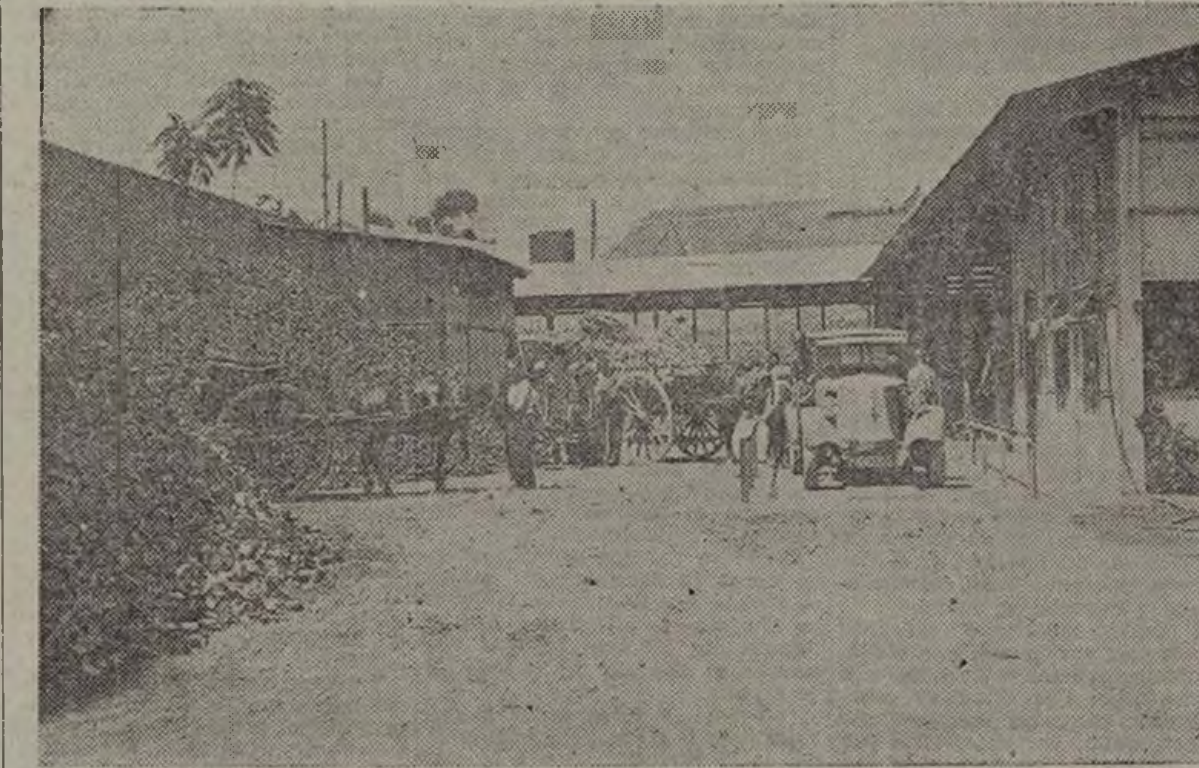
Vista parcial del almacén que la Sección de Carbones del Sindicato Unico Mercantil posee en la calle de Cortes Valencianas
