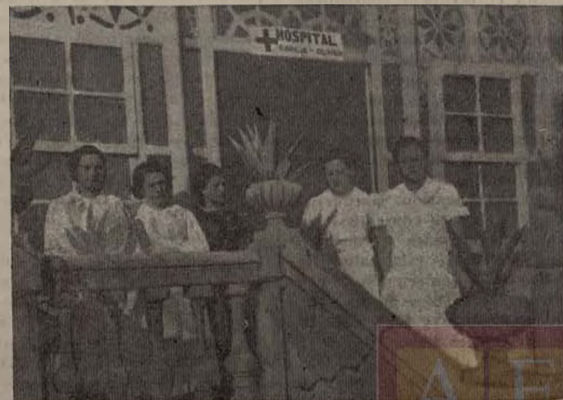
He aquí uno de los varios y a cual más noble aspecto de la colaboración de la mujer en nuestra lucha. Ese aire y esa sol que en este brave paréntesis reciben en la terraza del Hospital, inyecta nuevas energías físicas a las enfermeras laicas que les permite continuar su obra humanitaria. La inyección moral para sus almas son los elevados ideales libertarios.
