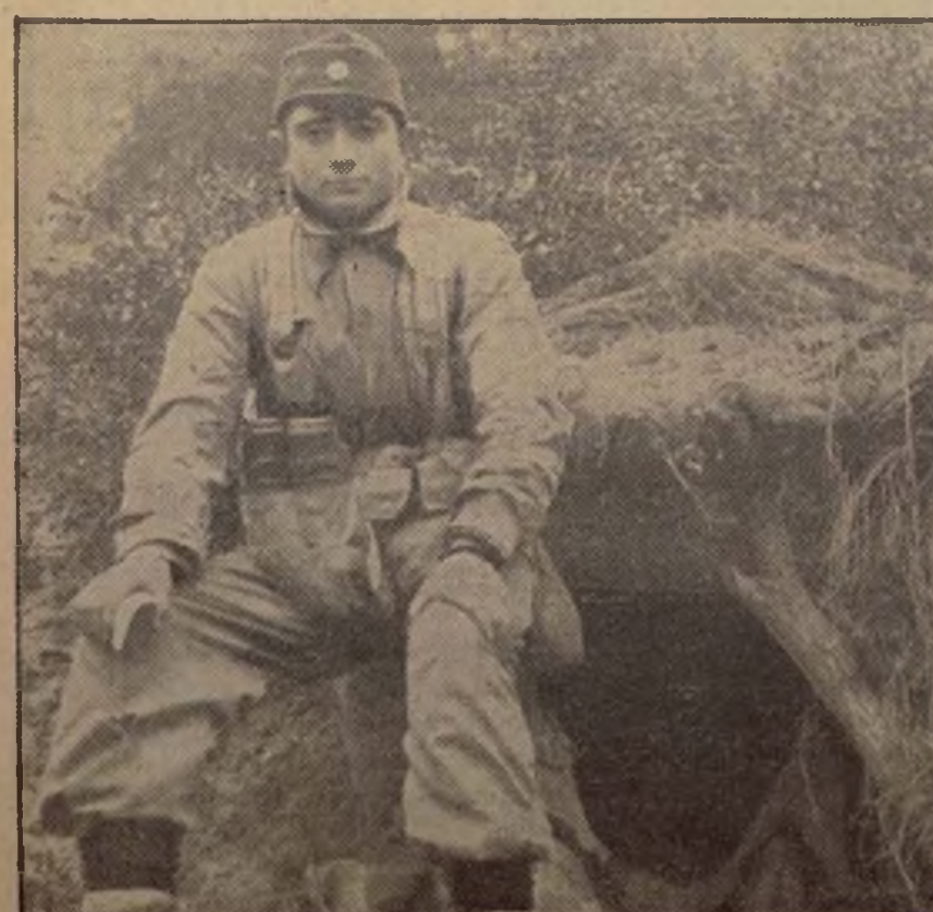
Decidido a contraatacar, en cintura las bombas, espera las órdenes de su mando. (Foto: Mayo)
