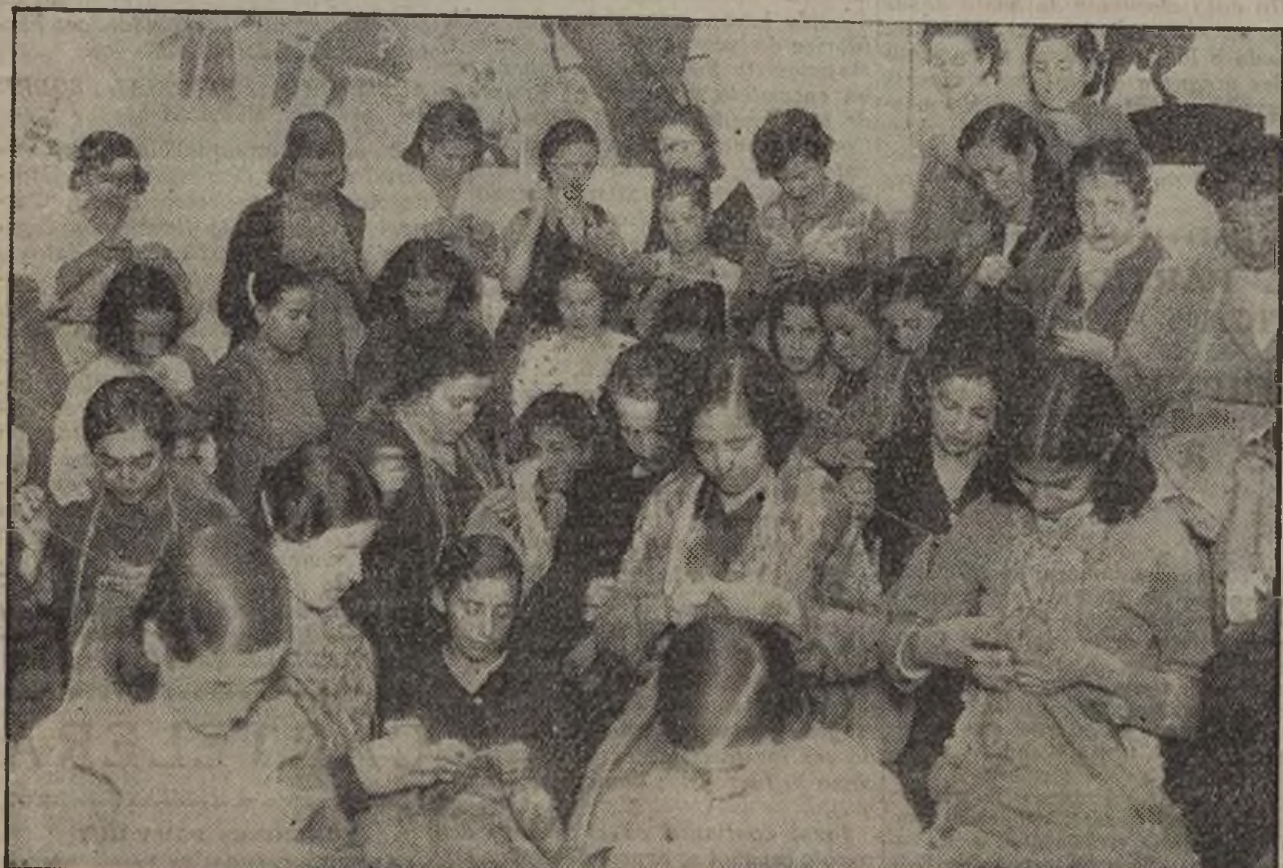
Grupos de mujeres cosen sacos terreros para construir parapetos. (Foto Mayo.)
