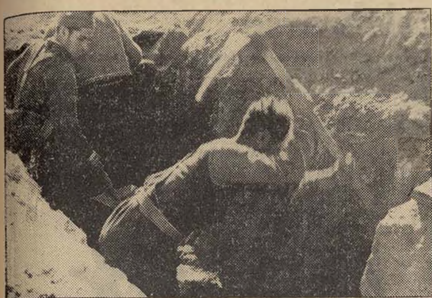
FRENTE DEL DUERO.—Trabajos de fortificación.
