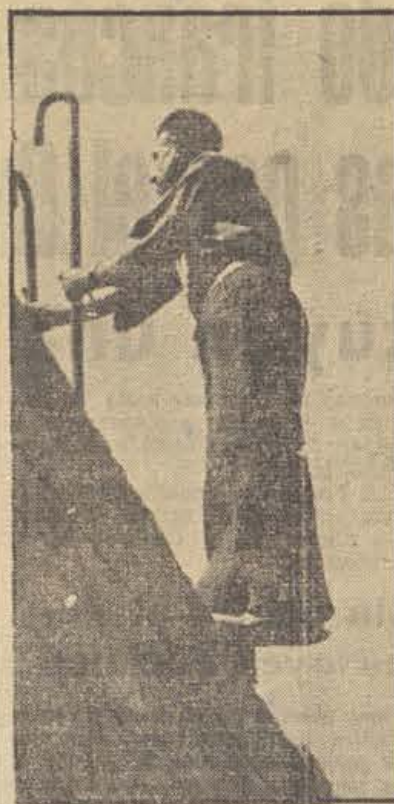
El obrero contempla las obras del refugio, que pronto estará terminado
