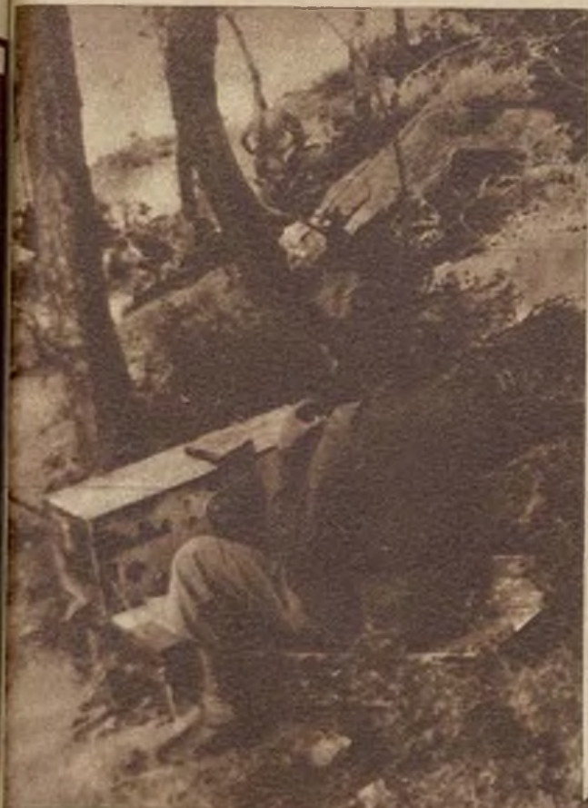
Estación emisora de un Estado Mayor.
