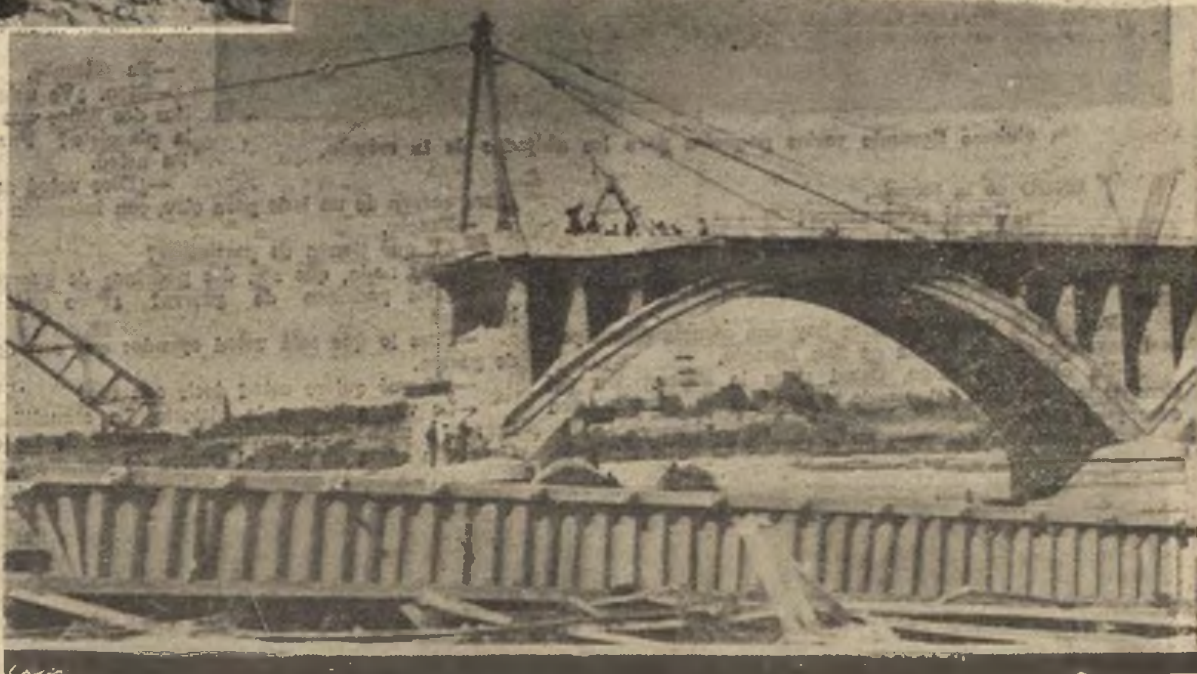
La impotencia de los rojos desahoga su furia destruyendo los puentes.
