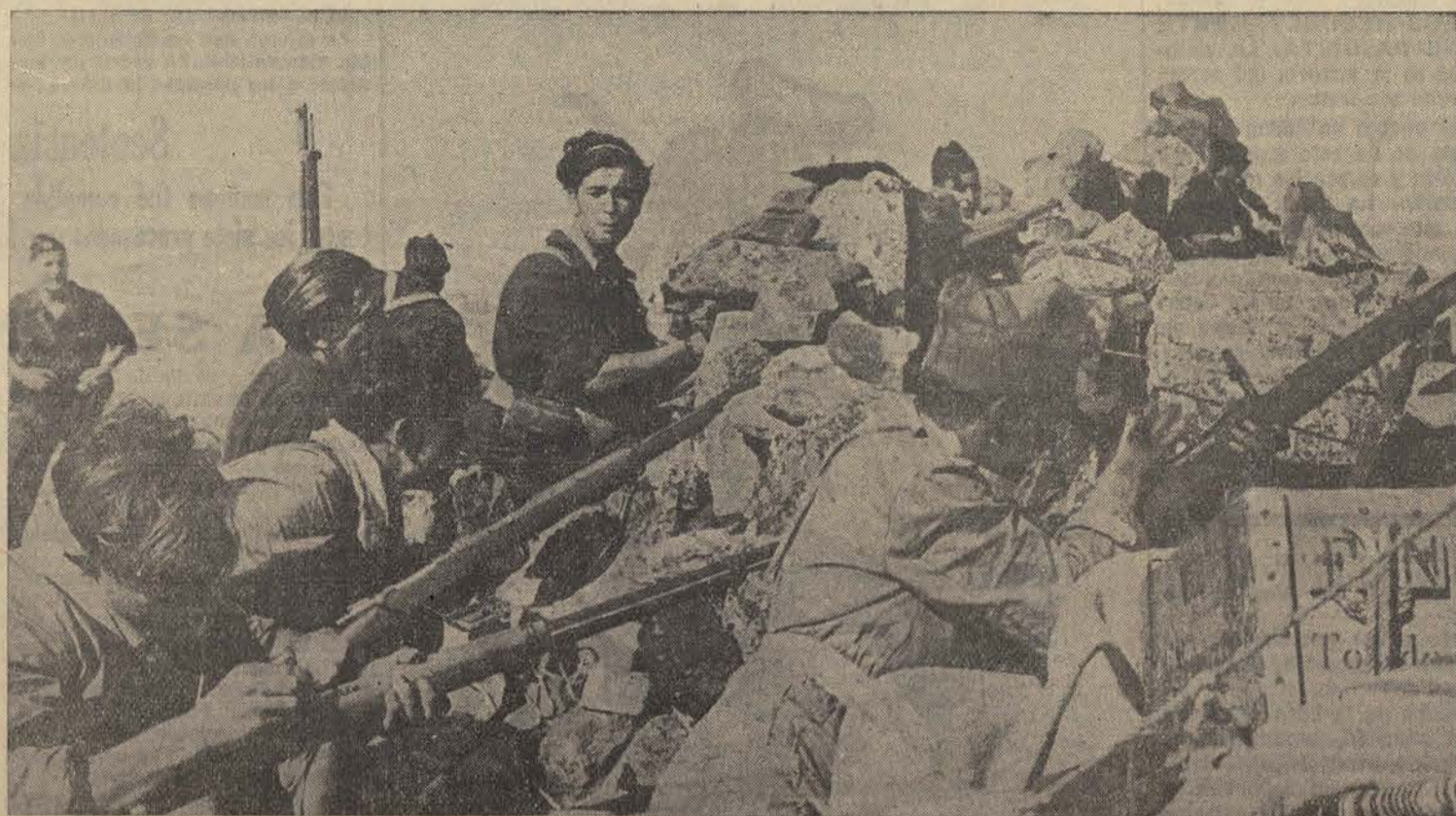
UNA AVANZADILLA DE LA COLUMNA MANGADA
