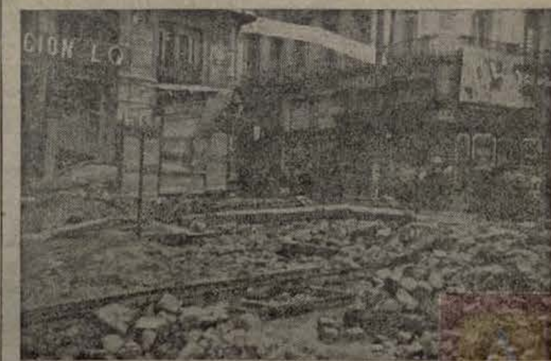
Vista parcial de la Puerta del Sol, donde se pueden apreciar los efectos producidos por una de las bombas que ha lanzado la aviación enemiga. (Foto Vidal.)
