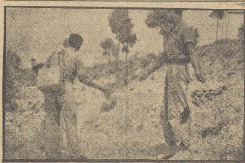
TENDIDO DE UNA LÍNEA TELEFÓNICA, POR SOLDADOS DE TRANSMISIONES
