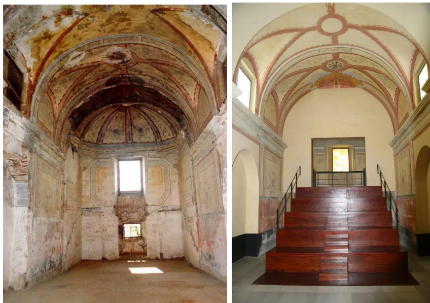
El mismo espacio de la capilla de la Salud, poco antes de su restauración, y tras acabar la misma. (Ramon Josa)
