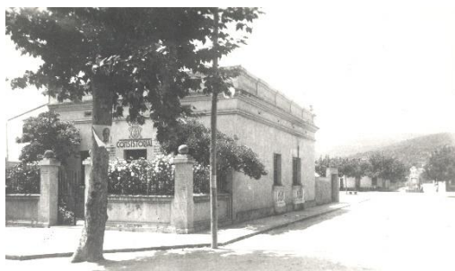
Imagen del que fue el edificio del ayuntamiento, situado entre las actuales Av. de la Constitución y C/ Dr. Trueta, desde mediados de 1938 hasta el año 1951, fecha en la que se inauguró el actual en la Pl. de la Iglesia. (Arxiu Municipal de Castelldefels)
