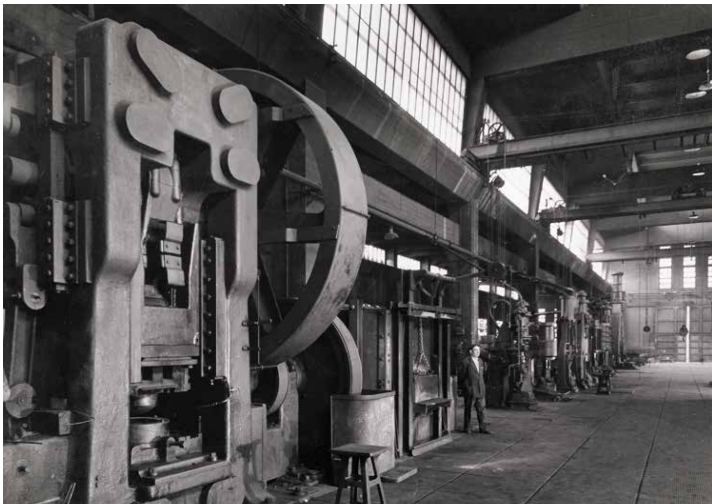
Altzairuen Forja. / Forja de Aceros. 1954. © Juan Miguel Pando Barrero - I.P.C.E. (GSM).
