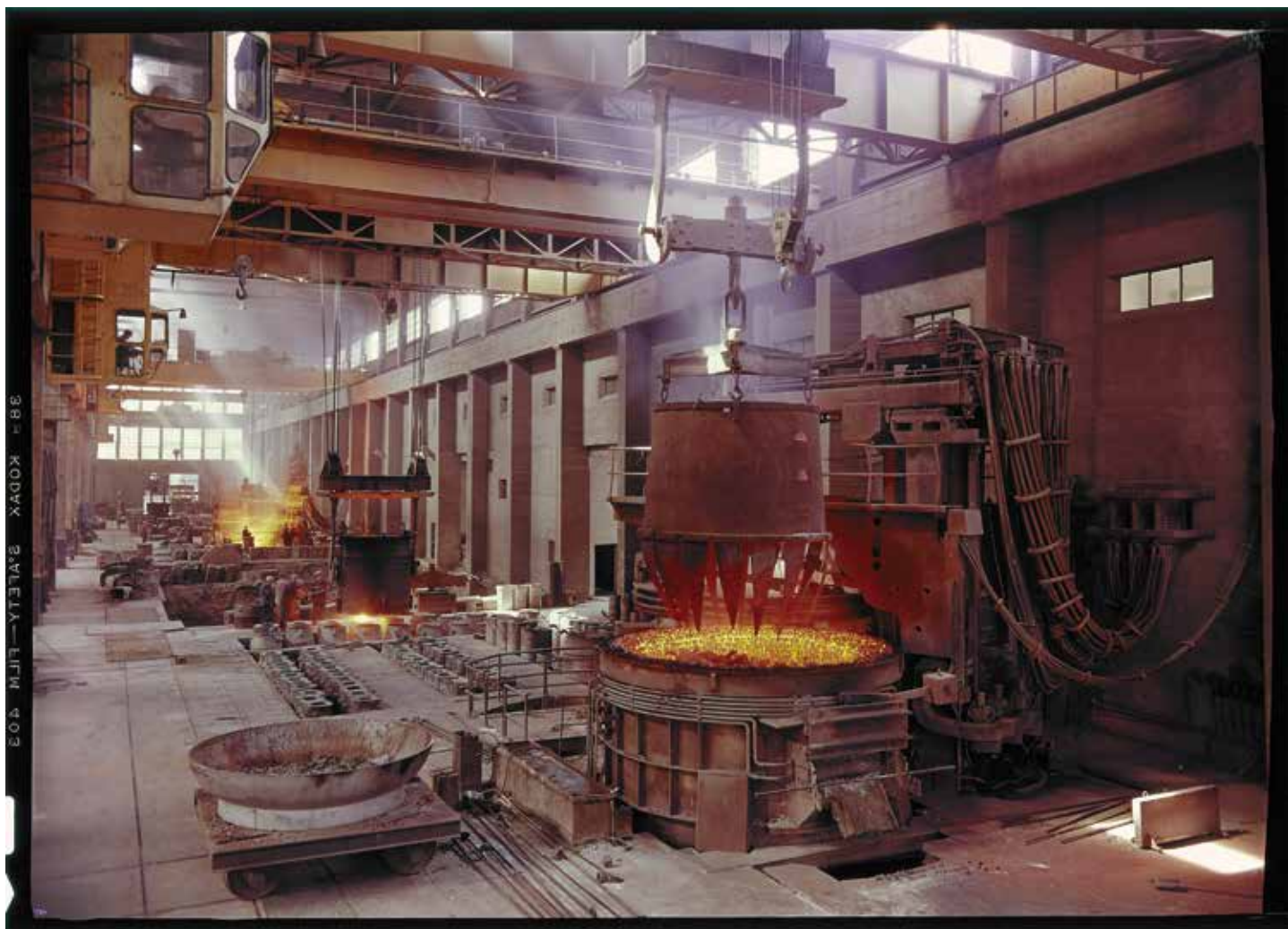
Fundizio Berria. / Fundición Nueva. ca. 1967. © Imprenta Industrial. (CPESA).
