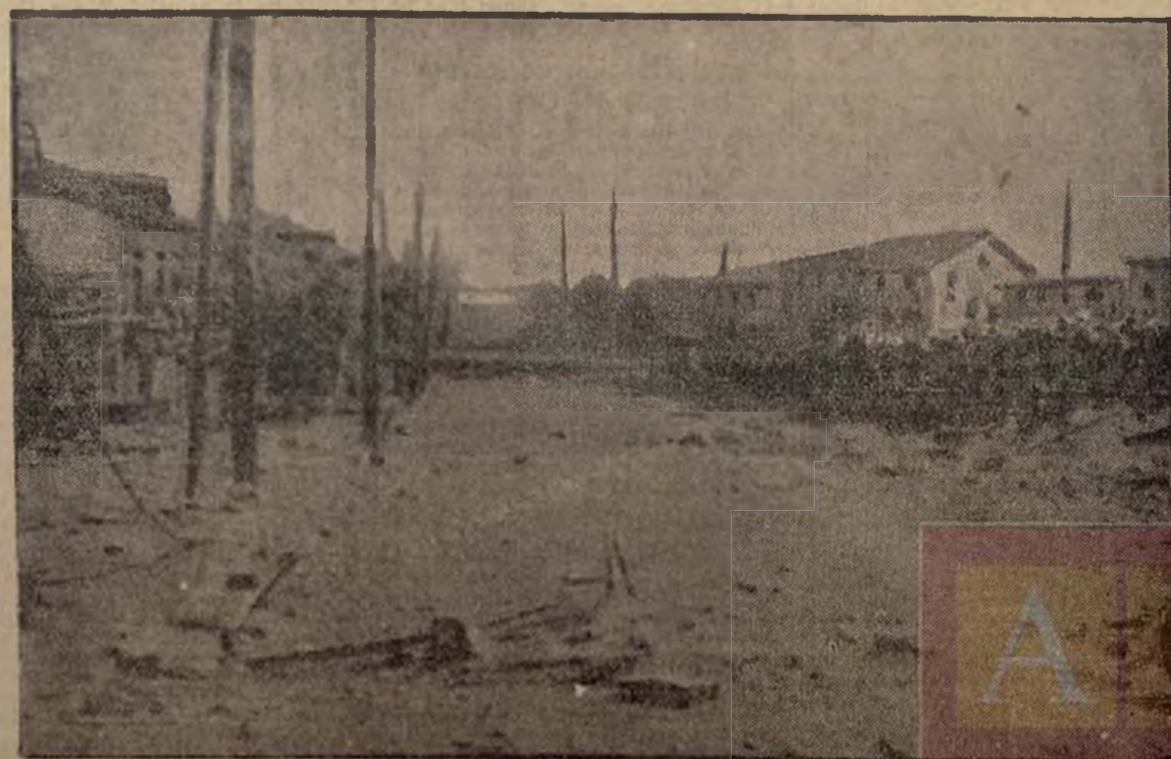
Las casas, las fábricas, una pared en pie, sirven de parapeto a los faciosos. Nuestra artillería ha derrocado, como en el pueblo del grabado, de lo que fueron construcciones de paz y de trabajo
