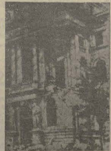
La fachada del ministerio de Obras Públicas muy afectada por el bombardeo
