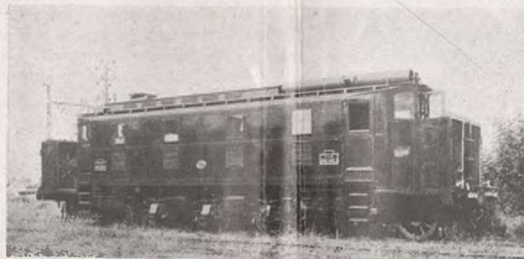
Locomotora eléctrica P. L. M. de corriente continua 3000 voltios y 74 toneladas de peso
